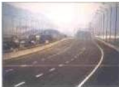
New Taipei Freeway (Taiwan) 65.000 mp tratat cu RADCON #7 pentru a impermeabiliza 4 Km de autostradă suspendată, înainte de aplicarea asfaltului.
